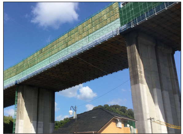
足場の設置（イメージ）
