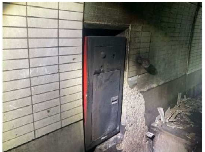
九州自動車（熊本）でのトンネル車両火災
